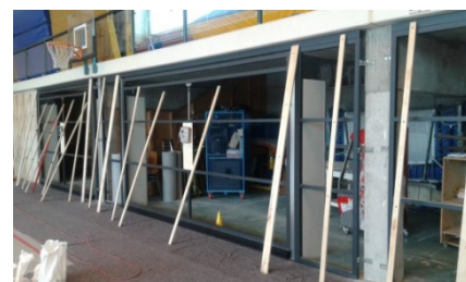
die unfertigen Geräteboxentore
