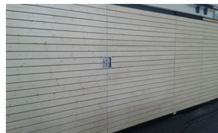
die fertigen Geräteboxentore
